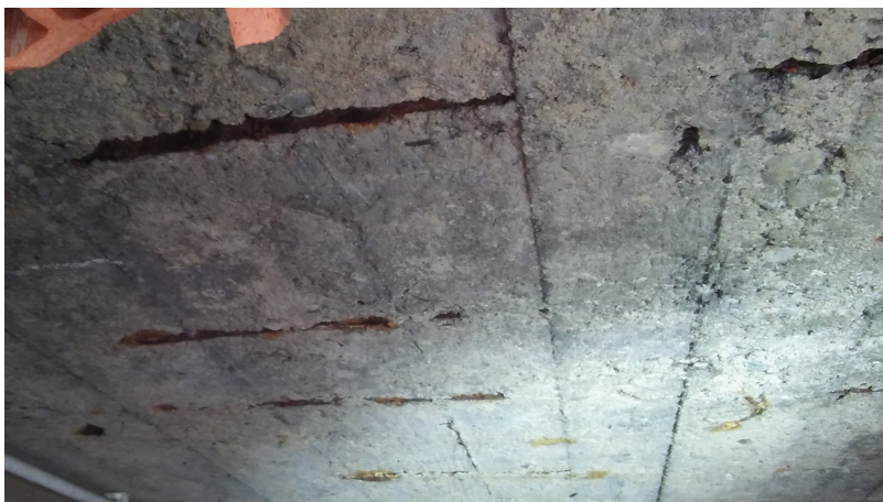
Korozja zbrojenia stropu
