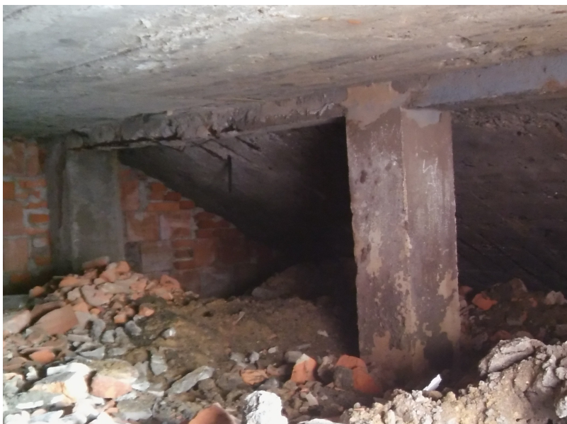
Uszkodzenia belki żelbetowej
